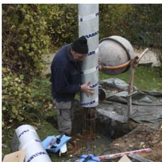
Ensuite on réalise une coulée de béton dans le tube (avec précautions pour garder une bonne verticalité). Il est nécessaire de «faire vibrer» le coffrage (petits coups de maillet de bois, par ex. ) pour éliminer les bulles et assurer un remplissage optimal. L'ensemble sera contrôlé et sécurisé par les gabarits en bois pour le positionnement des tiges filetées et éventuellement par un gîtage provisoire pour la verticalité si la masse de terre ne suffit pas.
