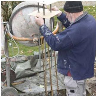
Le point suivant demande une certaine précision de travail: les trois tiges filetées (16mm x 100cm) en inox sont soudées aux fers à béton en respectant une disposition triangulée et la hauteur décidée (en s'aidant de gabarits en bois par ex.). Ici, elles plongent d'environ 80 cm dans le coffrage, la partie émergeant du coffrage final pouvant éventuellement être coupée plus tard.
